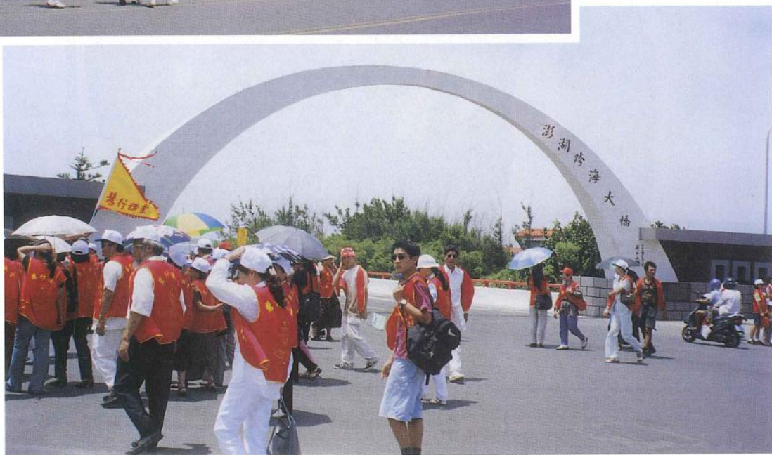
▼ 澎湖跨海大橋
